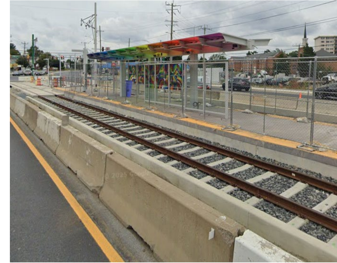
Estación Piney Branch Road de la Línea Púrpura (En construcción)
