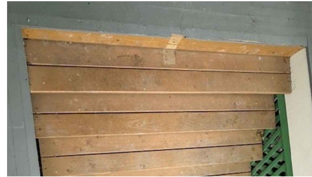
6 EXISTING LANDING DECKING A5 SCALE N.T.S.
