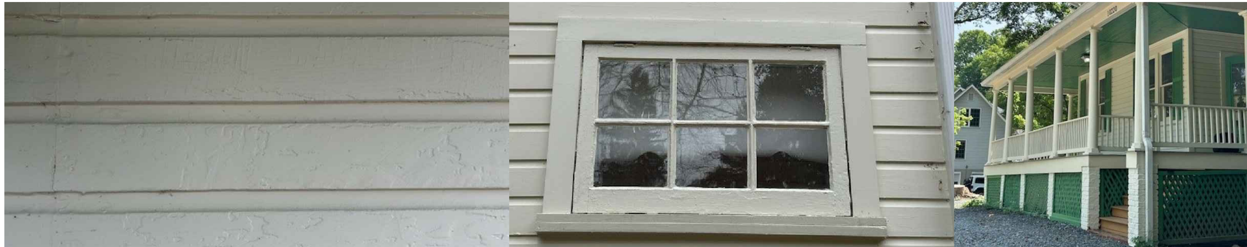
1 EXISTING DUTCH SIDING A5 SCALE N.T.S.
