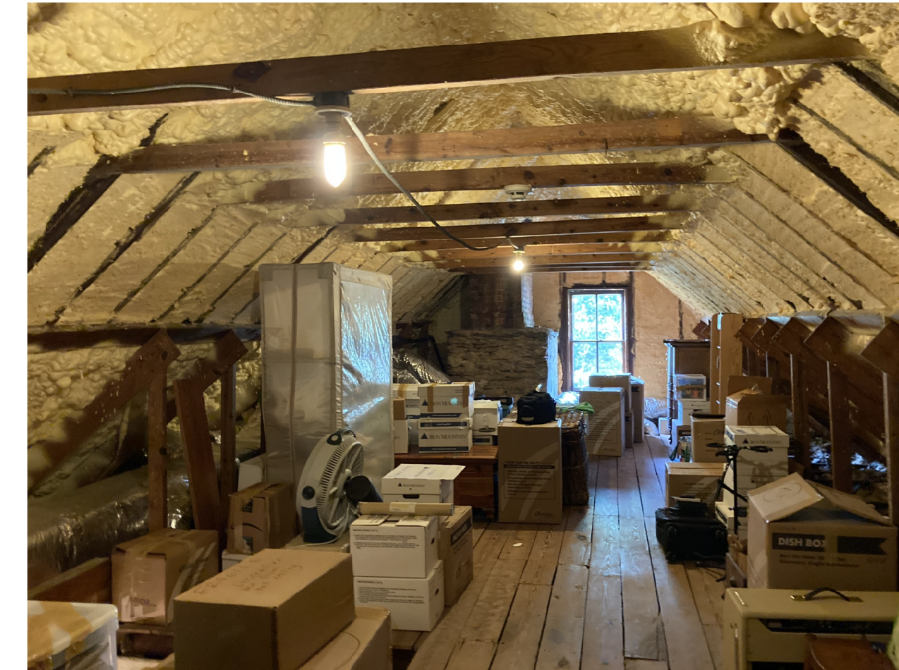
7 A-11 EXISTING ATTIC N.T.S.
