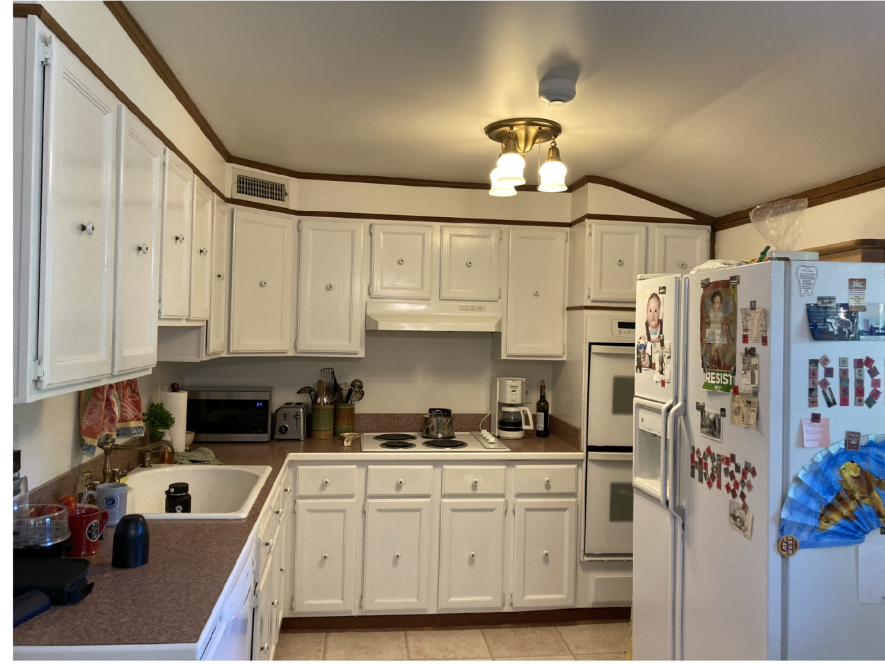
1 A-11 EXISTING KITCHEN N.T.S.
