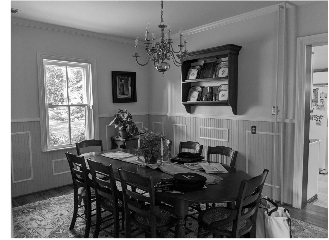
4 A-11 EXISTING DINING ROOM N.T.S.
