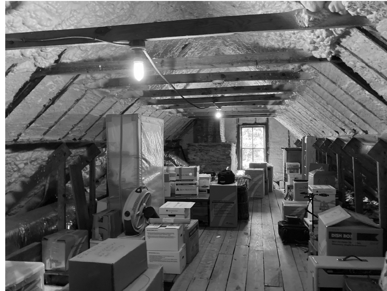
7 A-11 EXISTING ATTIC N.T.S.
