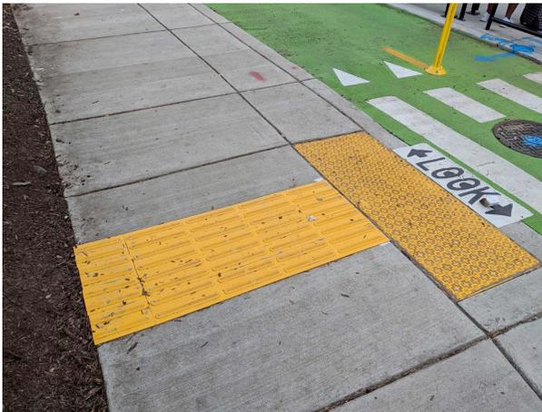
*Ejemplo de un indicador táctil de superficie para caminar (Tactile Walking Surface Indicator, TWSI) utilizado en el condado de Montgomery para dirigir a las personas con discapacidades visuales a una parada de autobús flotante.*
