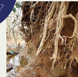
Exposed tree roots Raíz de árbol expuesta
