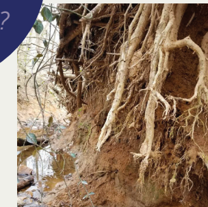
Exposed tree roots Raíz de árbol expuesta
