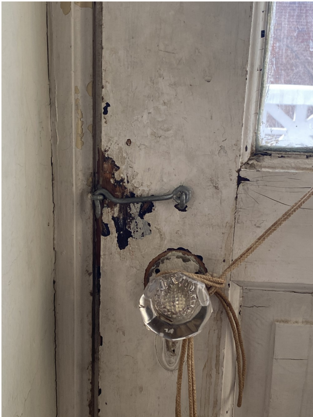
Existing Bedroom door detail
