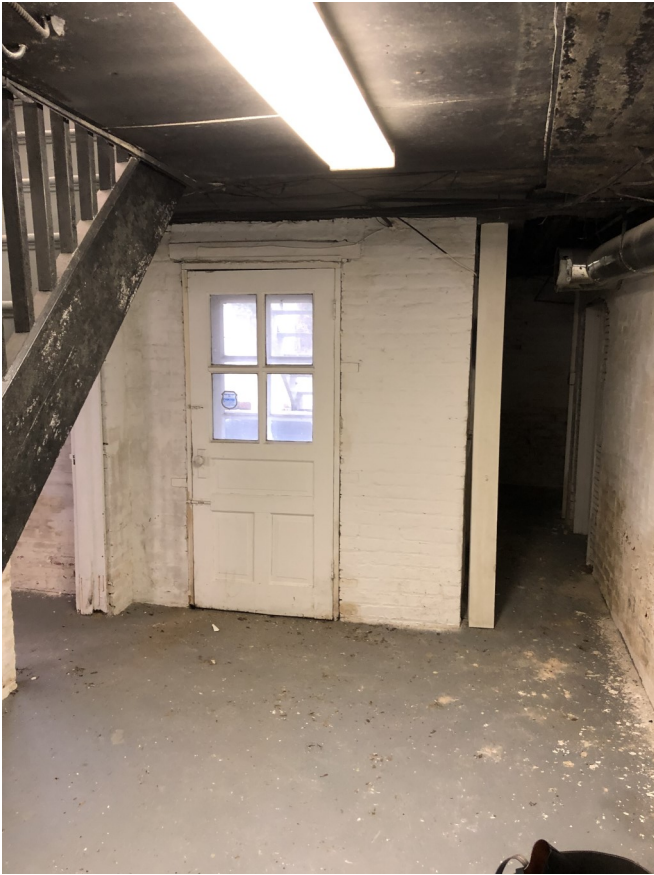
Existing Basement Door
