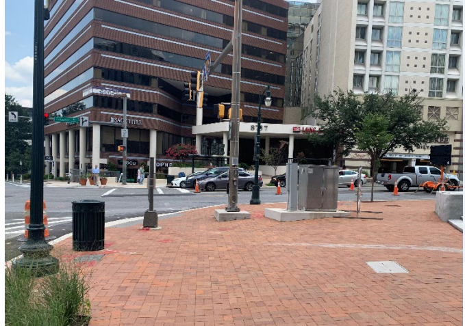
银泉 (Silver Spring) 市区人行道上的交通信号灯控制柜。
