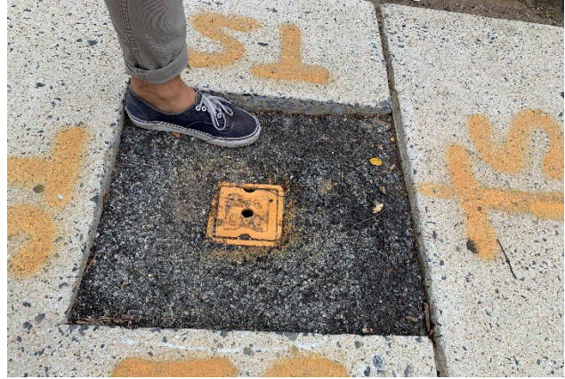
人行道上一个填充不良的公用设施开口。用鞋子进行测量。
