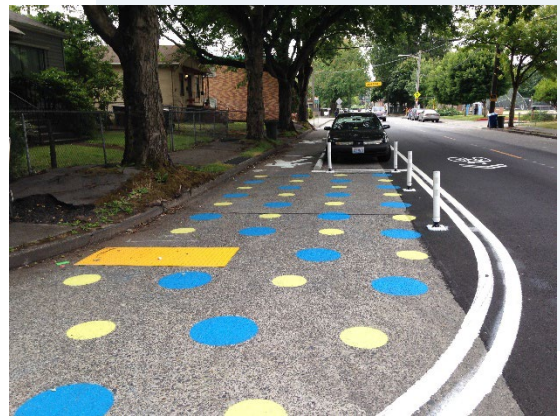
街道上一条画有图案的人行通道被停放的汽车、临时混凝土路缘和白色伸缩柱分隔开来。照片：Dongho Chang
