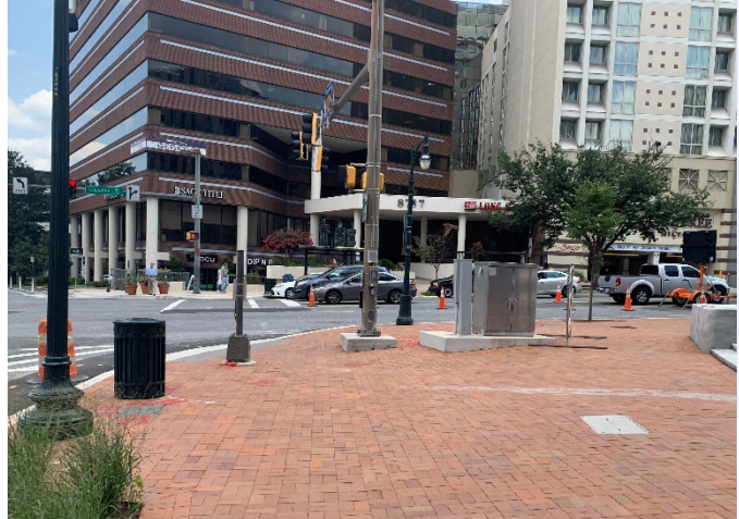
Gabinete de control de señales de tránsito en la acera en el centro de Silver Spring.
