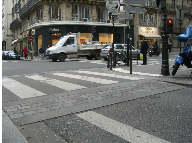
Un cruce elevado en el nivel de la acera a través de una calle de baja velocidad y bajo volumen. Foto: Vladimir Zlokazov
