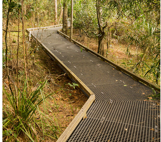
La pasarela metálica atraviesa el parque. Foto: Marco Specialty Steel
