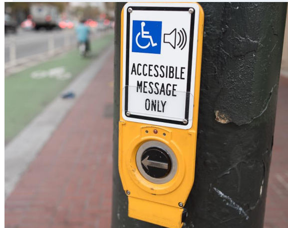
Una señal peatonal accesible dice "Solo mensaje accesible" y tiene una luz de confirmación. Foto: SFMTA
