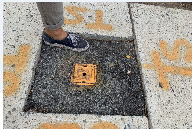
Un corte de servicios públicos mal rellenado en la acera. Calzado para fines de escala.
